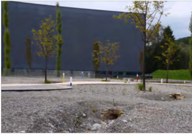
Sammelgräben. Das anfallende Regenwasser wird in Gräben gesammelt und weitergeleitet. Die Gräben bestehen wie das übrige Gelände nur aus mineralischen Substraten. Es gibt keinen unkrautverseuchten Mutterboden, der eine artenreiche naturnahe Gestaltung erschweren würde. Die Gräben und Flächen dazwischen werden als Feucht- und auch als Trockenstandorte bepflanzt und besät.
