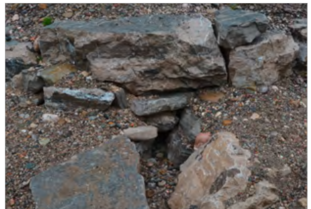
Regenwasserrohreinlauf. Alle Regenwasserrohre des 1000-m 2 -Daches werden nun an die Gräben angeschlossen. Es ist eingesät und gepflanzt und kann losgehen. Sage mir, wann der Regen fällt?
