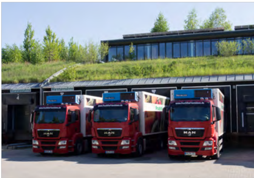
Flächenpotential und Synergien: Grüne Vielfalt auf dem Dach und Klimaschutz durch Reduktion der Kühllast beim Fruchthof Konstanz.
