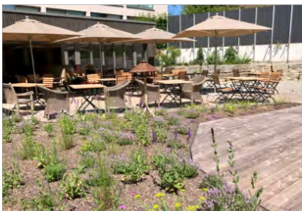
Die Frühstücksterrasse wird durch eine Dachbegrünung auf dem Boden in zwei Bereiche gegliedert. Darunter befindet sich der Wellness-Bereich des Hotels. Zuvor war es ein einfaches Flachdach mit Rundkiesabdeckung.
