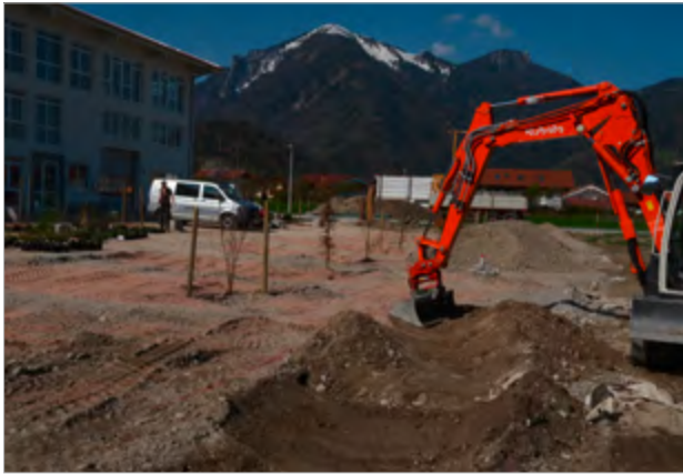
Vierseitengräben. In allen Himmelsrichtungen befinden sich am Ende die Versickerungsmulden und Gräben. Das macht über 150 m lfm Versickerung in Gräben von 2-5 m Breite. Sie liegen im reinen Kies. Und sie sollen alsbald erblühen. Doch wie?
