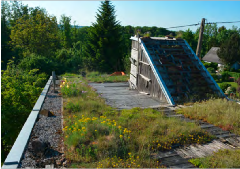
Dachbegrünung über unserem Bürogebäude im Sommeraspekt.
