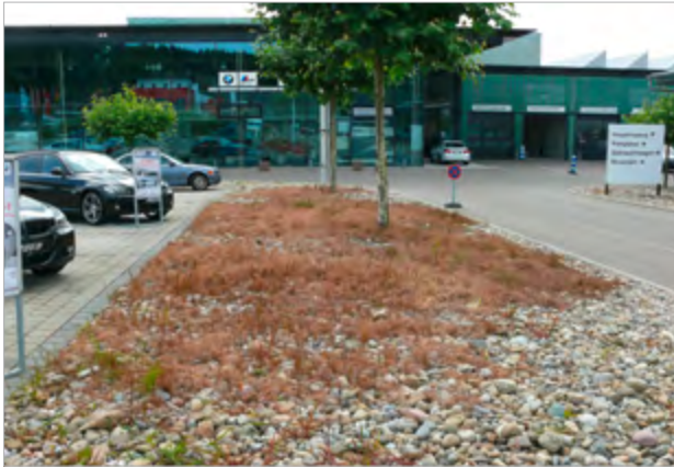
Sanierung dringend erforderlich: Wurzelunkräuter erobern massenhaft die „repräsentative“ Zufahrt zum neuen modernen Autohaus
