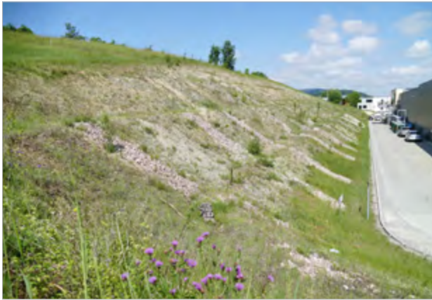
Rohbodenbegrünung im Heudruschverfahren, Magerrasen mit verlangsamttem Sukzessionsprozess, aktuelle Bedeckung etwa 40% - fast pflegefrei
