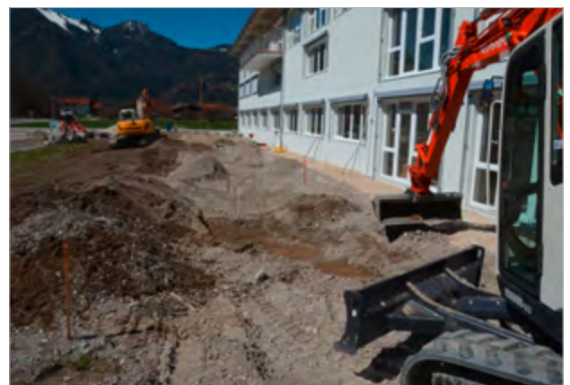
Modellierung der Versickerungsgräben. Pure Baggerarbeit. Aber kreativ. "Stell Dir ein mäandrierendes Flussbett vor!" Das ist die Aufgabe für den Baggerfahrer. Anfangs gar nicht so leicht. Aber bald hat er's geschnallt und schwingt sich rund ums Gebäude.
