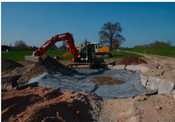
Naturteiche und Gumpen. Mit vier EPDM-Kautschukfolien werden außerdem Becken abgedichtet, damit das Wasser nicht nur temporär, sondern länger stehen bleibt. Das größte hier ergibt den Naturteich und späteren Mitarbeitersitzplatz. We'll see!
