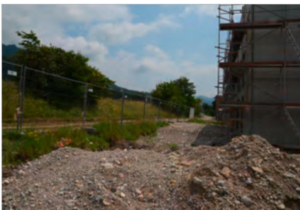
Gelände vorher. In der Aue der Tiroler Achen, einem echten Wildfluss der Alpen liegt das Gewerbegrundstück. Die Flusslage ist Aufgabe und Mahnung für den Planer: Gehe sorgsam mit dem Regenwasser um! Und leite es vor allem nicht in den Fluss! Das ist sogar verboten. Regenwasserversickerung als Muss am Fluss.
