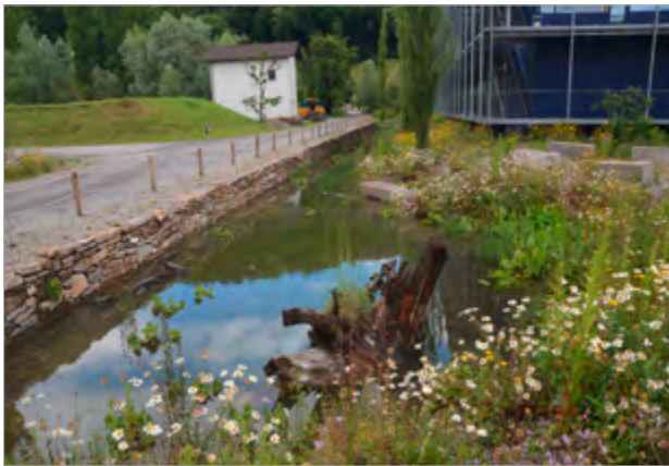
Großer Wassergraben. Er sammelt, hält und versickert nach und nach das anfallende Regenwasser vom Gelände und ist gleichzeitig ein wichtiger Lebensraum für Tiere, Pflanzen und Menschen.
